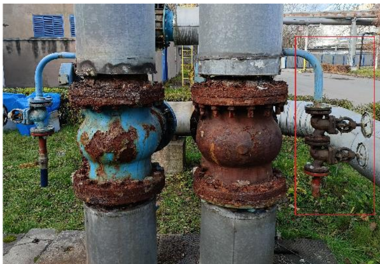
Odwodnienie rurociągu DN 350
