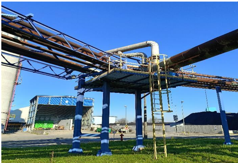
Estakada instalacji sprężonego powietrza
